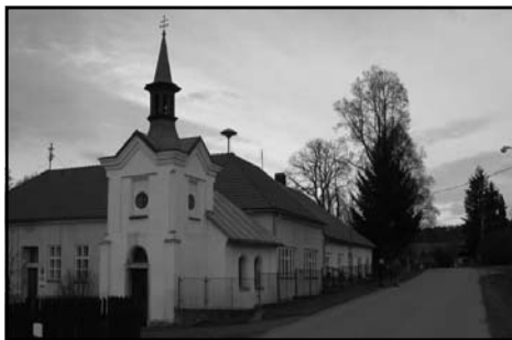
Budova nové školy s kapličkou Foto JUDr. M. Vopravil
