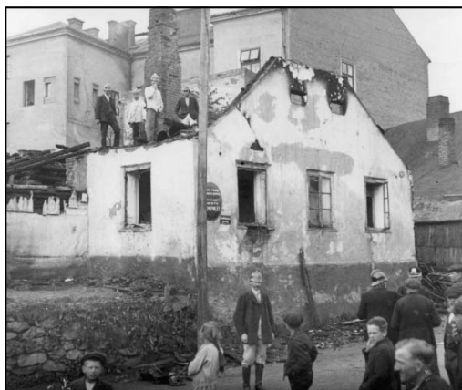
ruiny domů čp. 317 a část čp. 318
