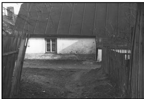
stavení čp. 332, nalevo část stavení čp. 333
