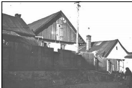
stavení čp. 329 a níže čp. 328
