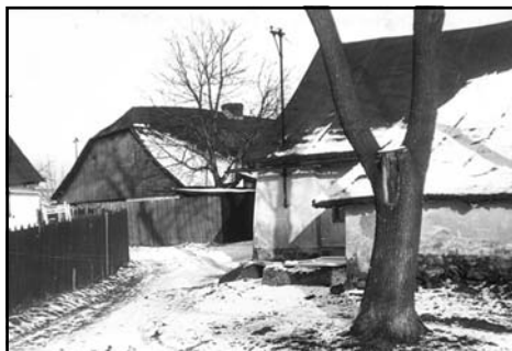
stavení čp. 338 (skanzen), za ním čp. 335
