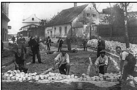
další pohled na domy u jihlavské ulice
