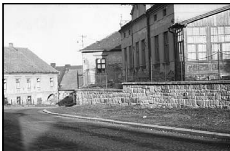
dům čp. 366, dříve z druhé strany přiléhalo dřevěné stavení čp. 368
