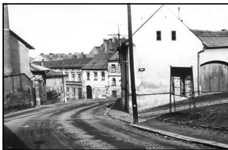
dům na místě bývalého stavení čp. 374
