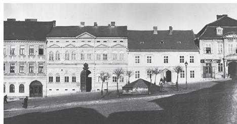
Tehdejší budova radnice
