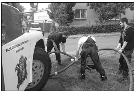
Tlakování a vymývání kanalizace Speřice.
