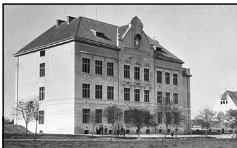
Budova v Hálkově ulici v roce 1909.
